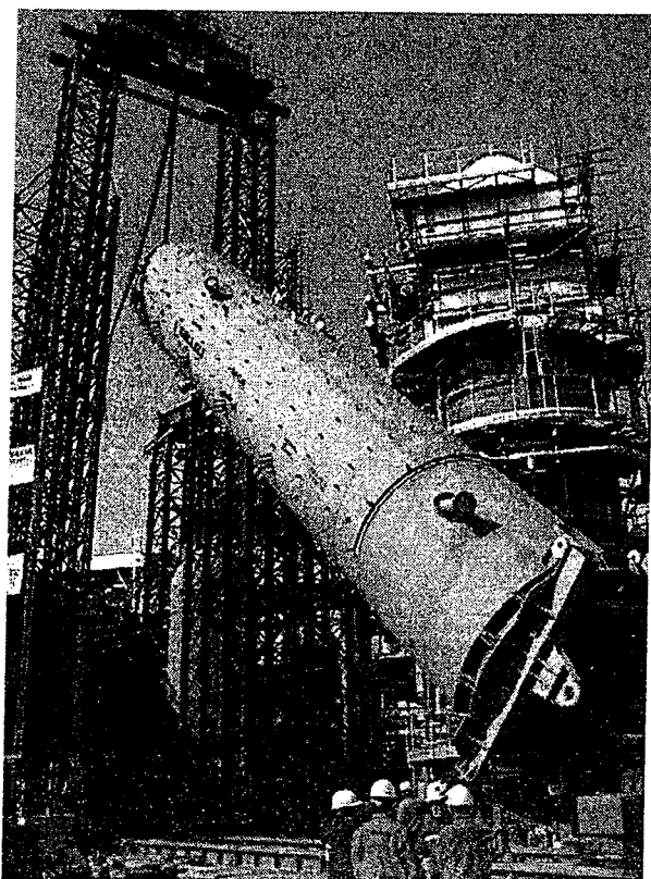
Obr. 5- Reaktor 65R701 počas zdvíhania
